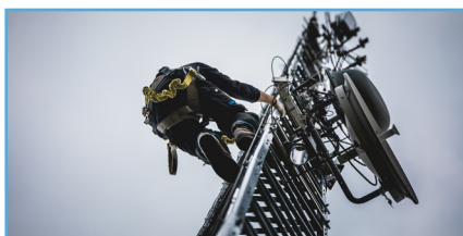
Instalare Echipamente Telecom
