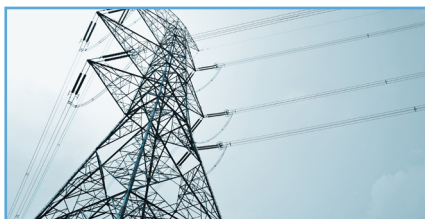
Instalări de Linii Aeriene de Joasă, Medie și Întă Tensiune
