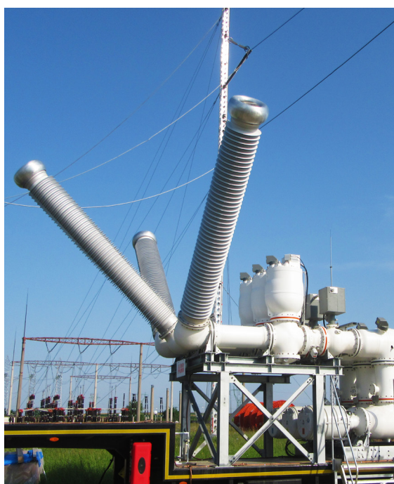
Celule mobile 400 kV în stațiile Bradu și Sibiu Sud
