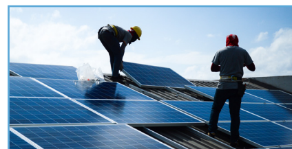
Instalare Echipamente Fotovoltaice
