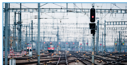
Instalarea Liniiilor Electrice Aeriene și Subterane pentru Căi Ferate
