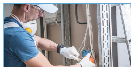
Instalare Aparate Electrice
