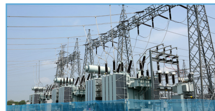
Instalarea Stațiilor Electrice de Întă Tensiune
