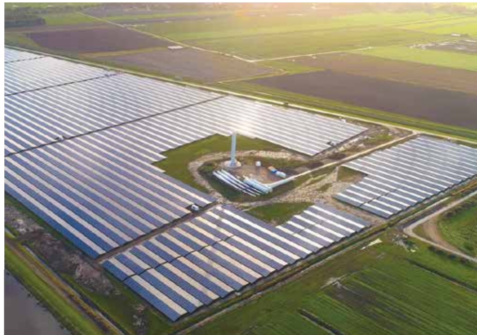
Duurkenakker Solar Power Plant
